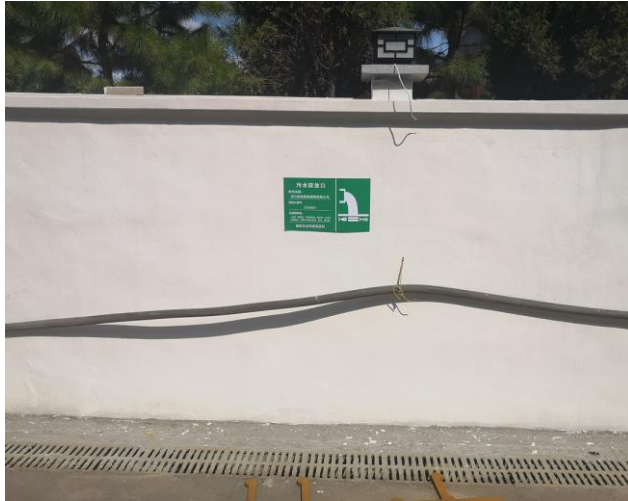
污水地埋排放口
